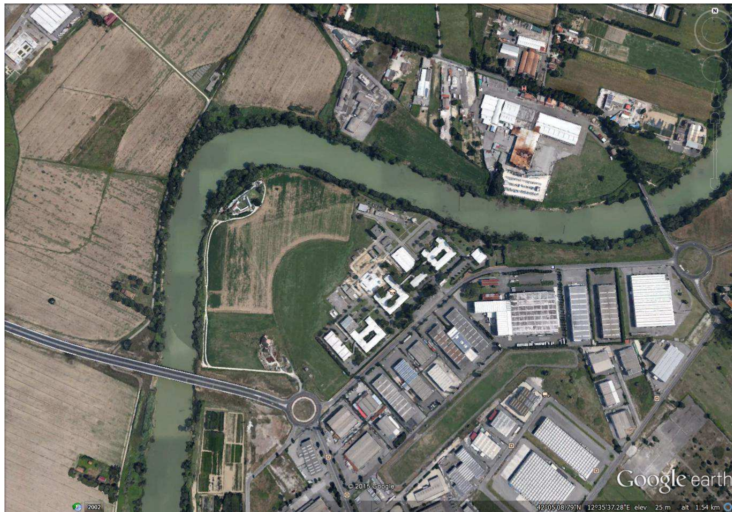
Figura 14: Foto satellite dell'area di Monterotondo particolareggiata - inquadramento CNR
